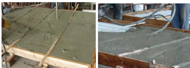
в) приемы уплотнения уложенной бетонной смеси Рисунок 2 – Изготовление фрагментов (стендов) сталежелезобетонной плиты перекрытия
