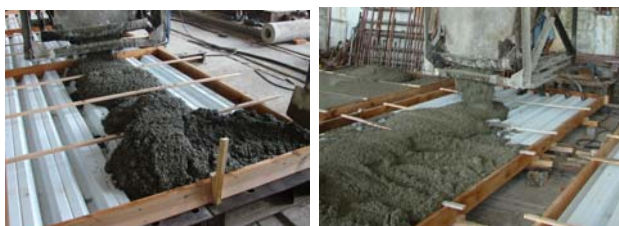
б) приемы укладки бетонной смеси и ее распределение по поверхности профнастила
